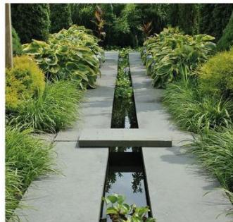
Exempel på dagvattenränna
