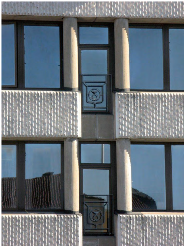
Franska fönster som pryds med kommunvapnet i smide bryter regelbundet av de tunga betongbjälklagen. Flankerande kolonner bidrar till att lätta upp intrycket.
