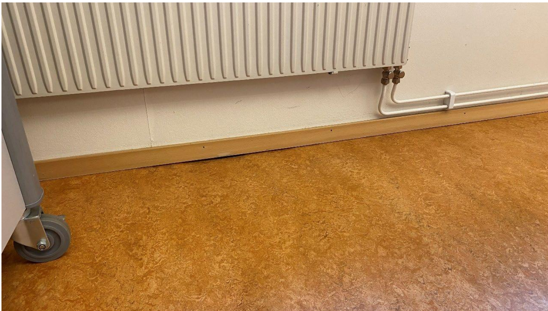
Foto 6. Fördjupning i betonggolvet vid yttervägg, ingen infiltration av uteluft detekterad, sal B121.
