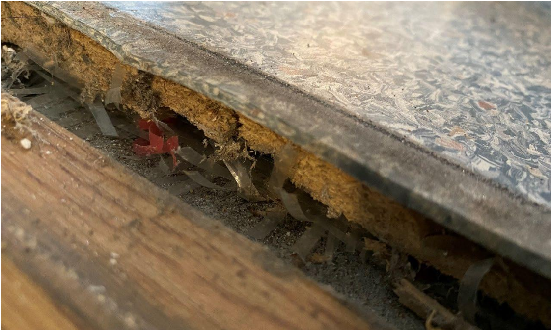
Foto 11. Närbild på renoveringsgolv i personalrum med uppfuktad träfiberskiva i tröskelområdet utan ångspärr.
