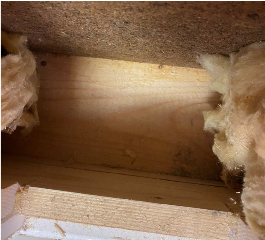
Foto 8. Frilagd yttervägg med synlig asfboardskiva (vindskiva) och sannolikt övre syll.
