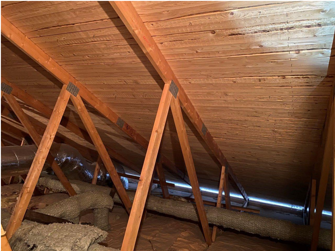
Foto 18. Vindsutrymme i hus B.
