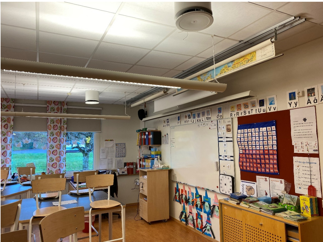
Foto 4. Sal B125. Linoleumgolv och två tilluftsdon synliga i taket.
