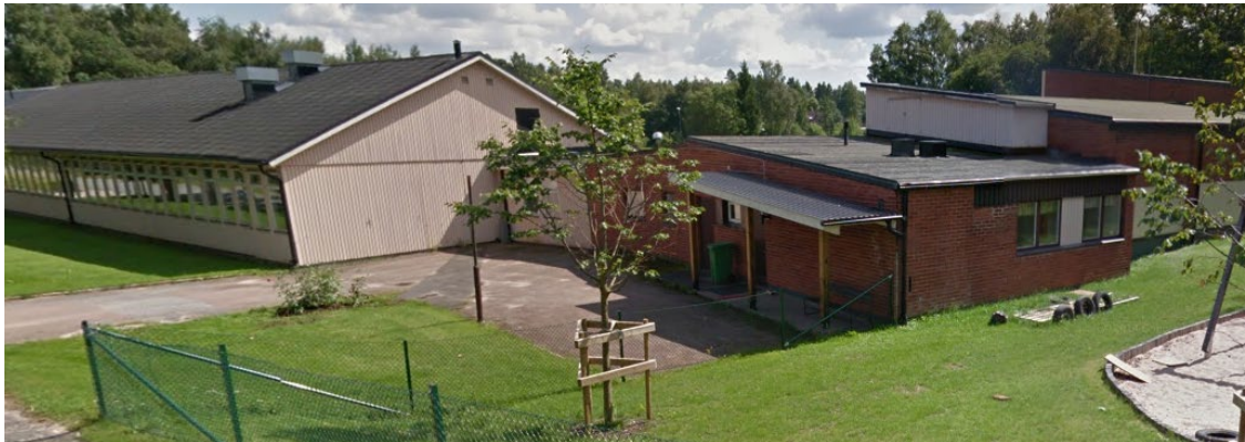
Foto 2. Klockaregårdsskolan med äldre hus A till höger och hus B till vänster i bild.
