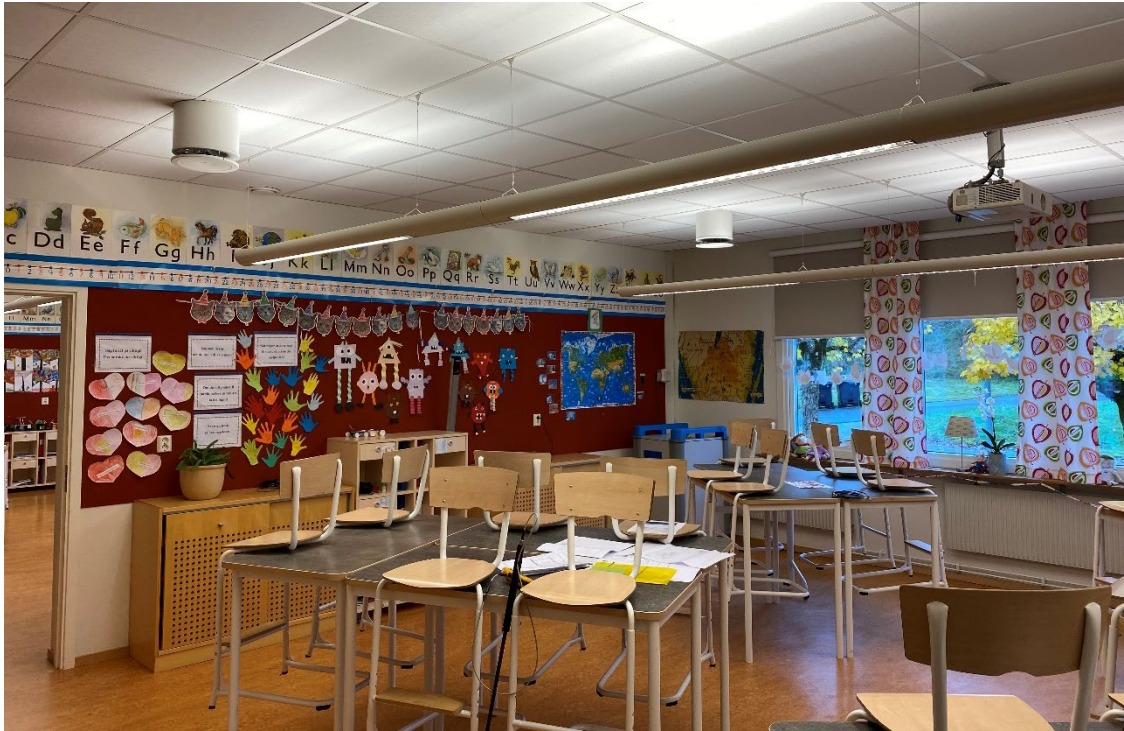
Foto 5. Bakre delen av sal B125 med två synliga tilluftsdon och frånluftsdon vid vägg/takvinkel.
