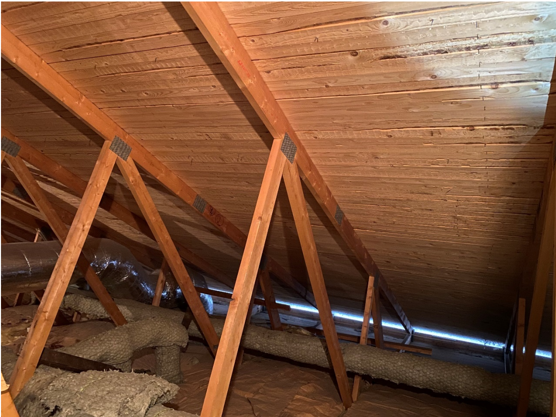
Foto 18. Vindsutrymme i hus B.
