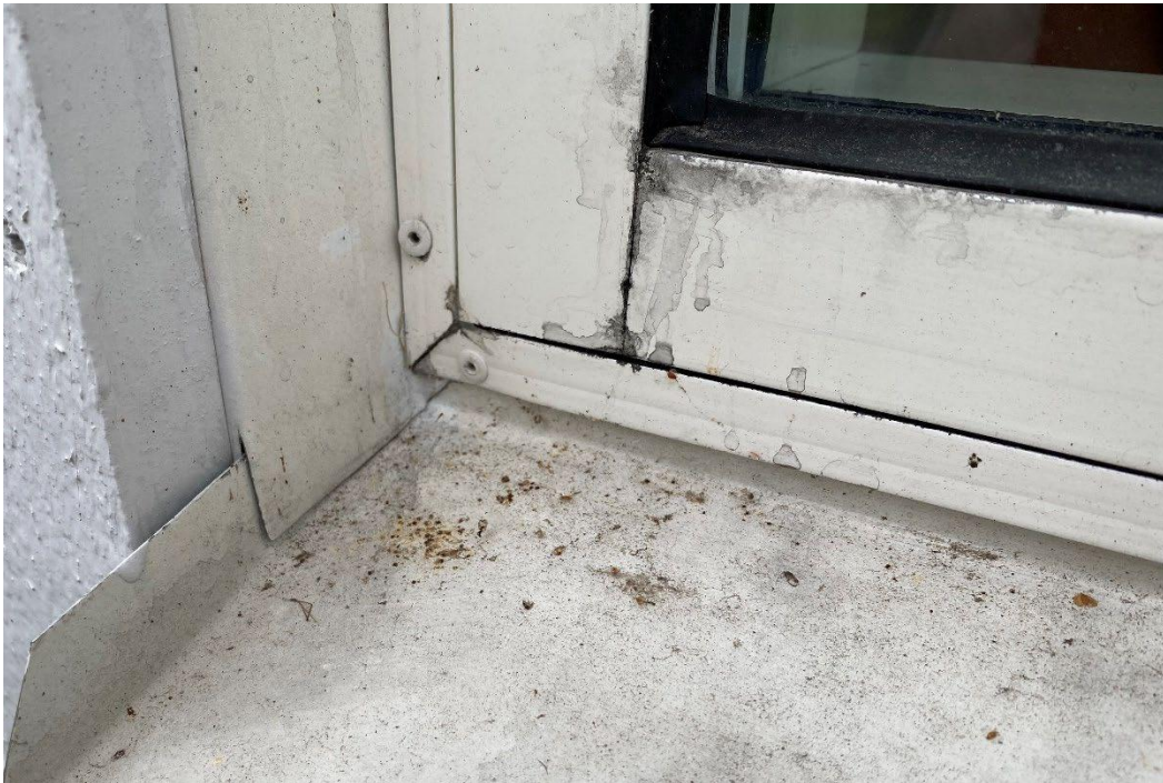
Foto 17. Exempel på bleck vid fönster.
