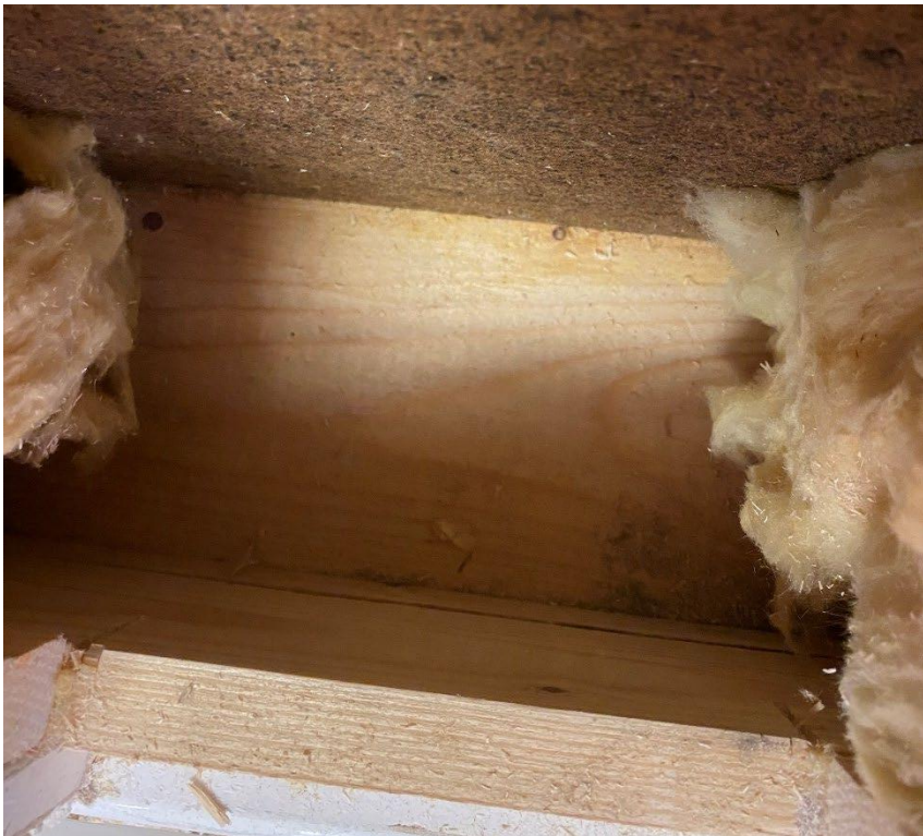
Foto 8. Frilagd yttervägg med synlig asfaboardskiva (vindsdåra) och sannolikt övre syll.
