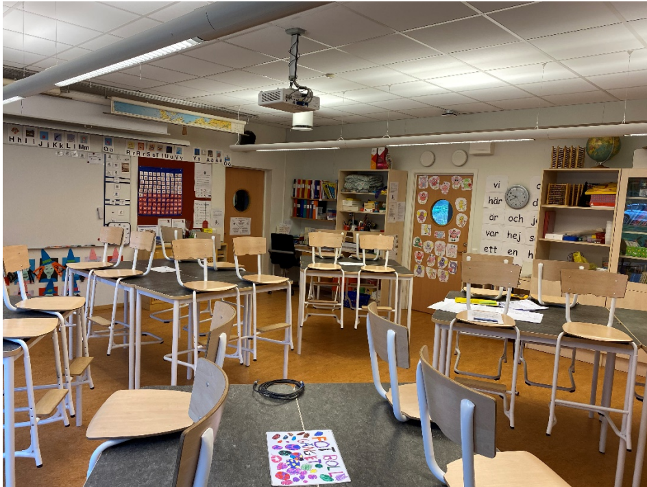
Foto 9. Sal B121. Överluftsdon synliga på innervägg mot korridor.
