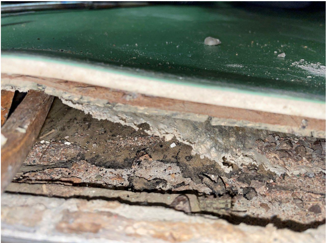
Foto 26. Renoveringsgolv med underliggande tjärpapp.
