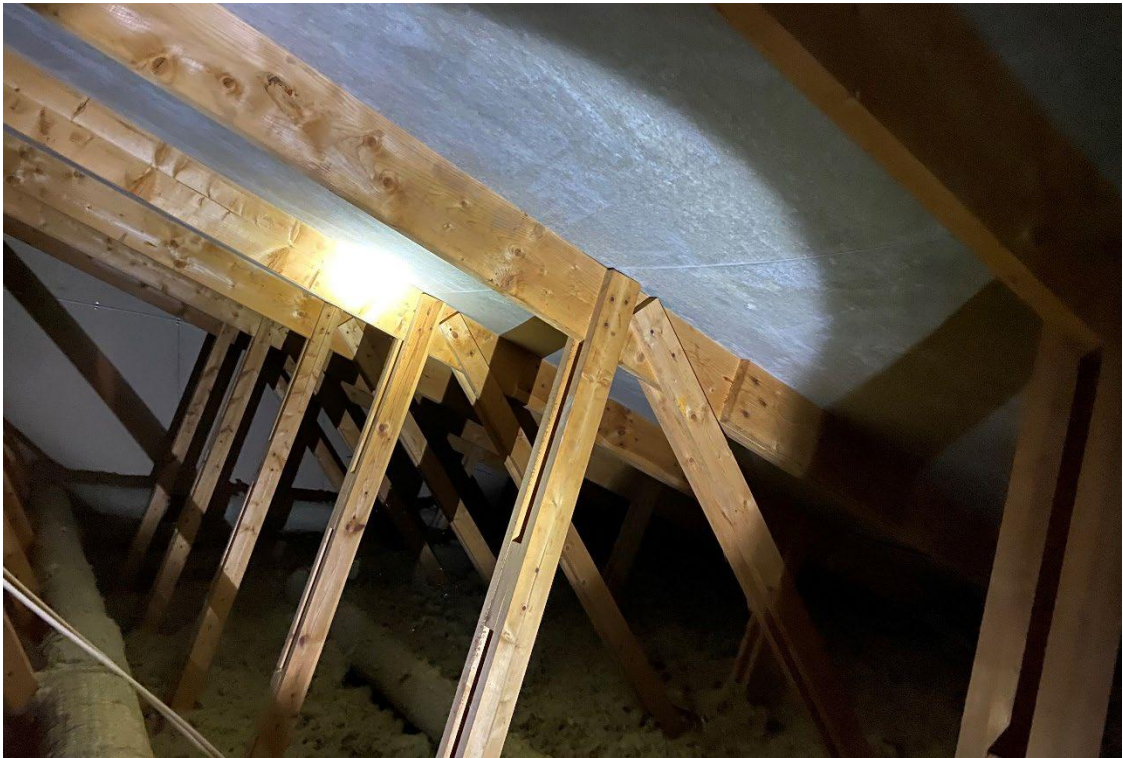
Foto 19. Ytterligare exempel på kallvind i hus B, här med oorganiska skivor.
