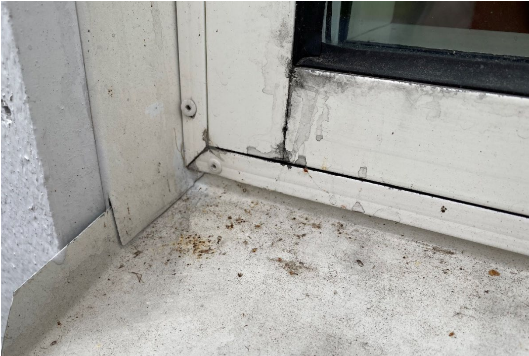
Foto 17. Exempel på bleck vid fönster.
