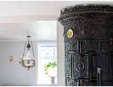
Kakelugnarna är original och behövde bara fixas till med nya fogar.
