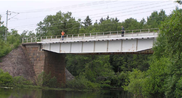
Järnvägsbron mellan Nissafors och Hestraviken.
