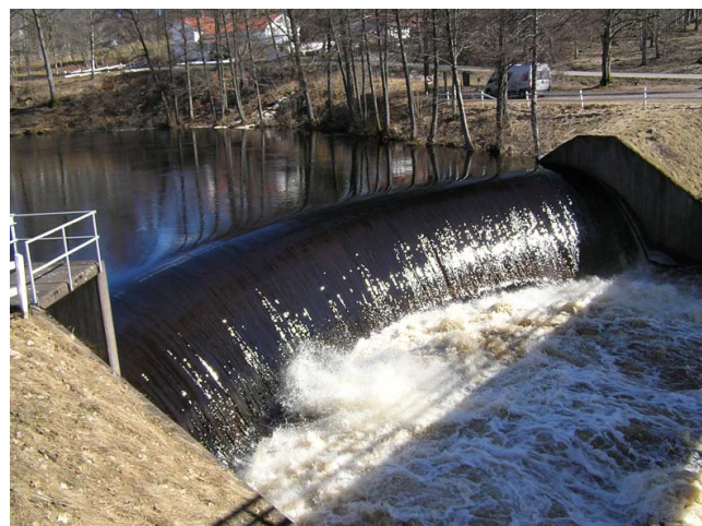
Dammen vid Nissafors Bruk.
