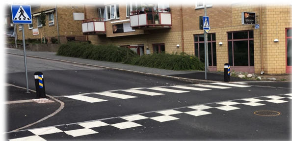
Figur 6. Förhöjt övergångsställe kombinerat med cykelpassage
