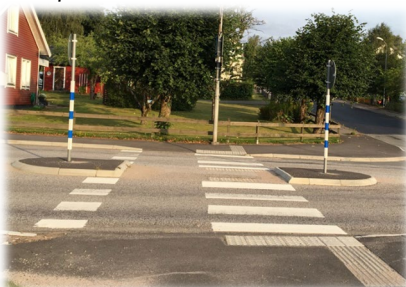
Figur 5. Övergångsställe kombinerat med cykelpassage och mittrefug med vilplan
