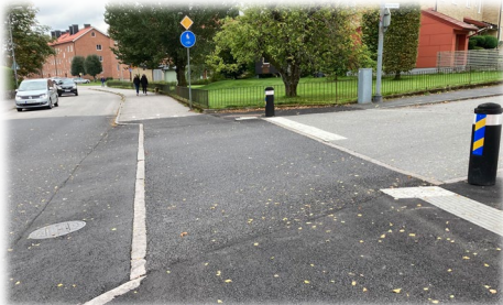
Figur 3. Förhöjd genomgående gcm-passage med ledstråk och taktila plattor
