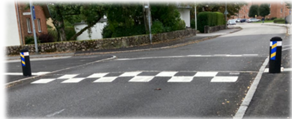
Figur 4. Förhöjd gcm-passage med ledstråk av taktila plattor
