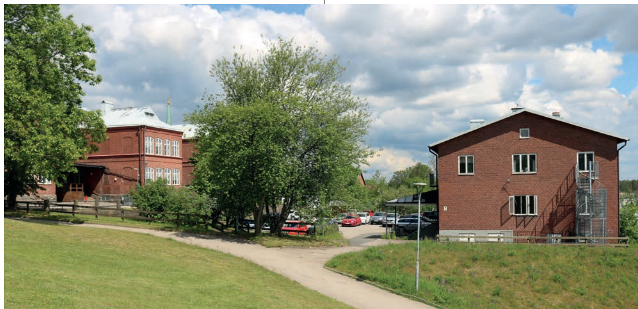
Skolbyggnaden och gymnastikalsbyggnaden sedda från söder.
