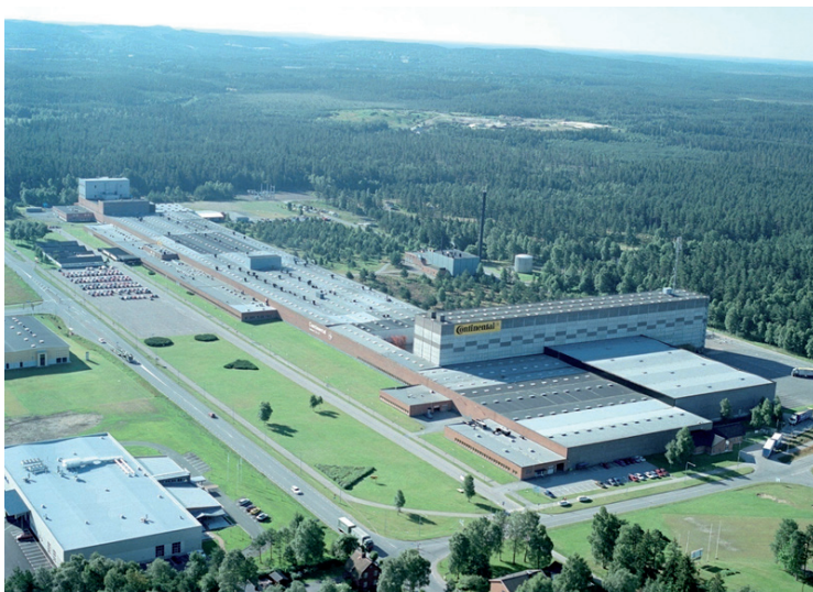
Flygbild över fabriksområdet. Bilden är tagen omkring 1998–1999, efter att högdelen i öster är uppförd, men innan lagerplattan öster om höglagret blir inbyggd under tak.
