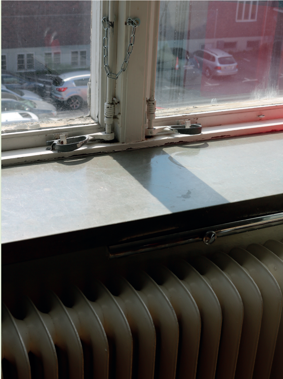
Ovanlig spanjolettösning på fönstersnickerierna och bevarade friskluftsventiler i krom från 1937.
