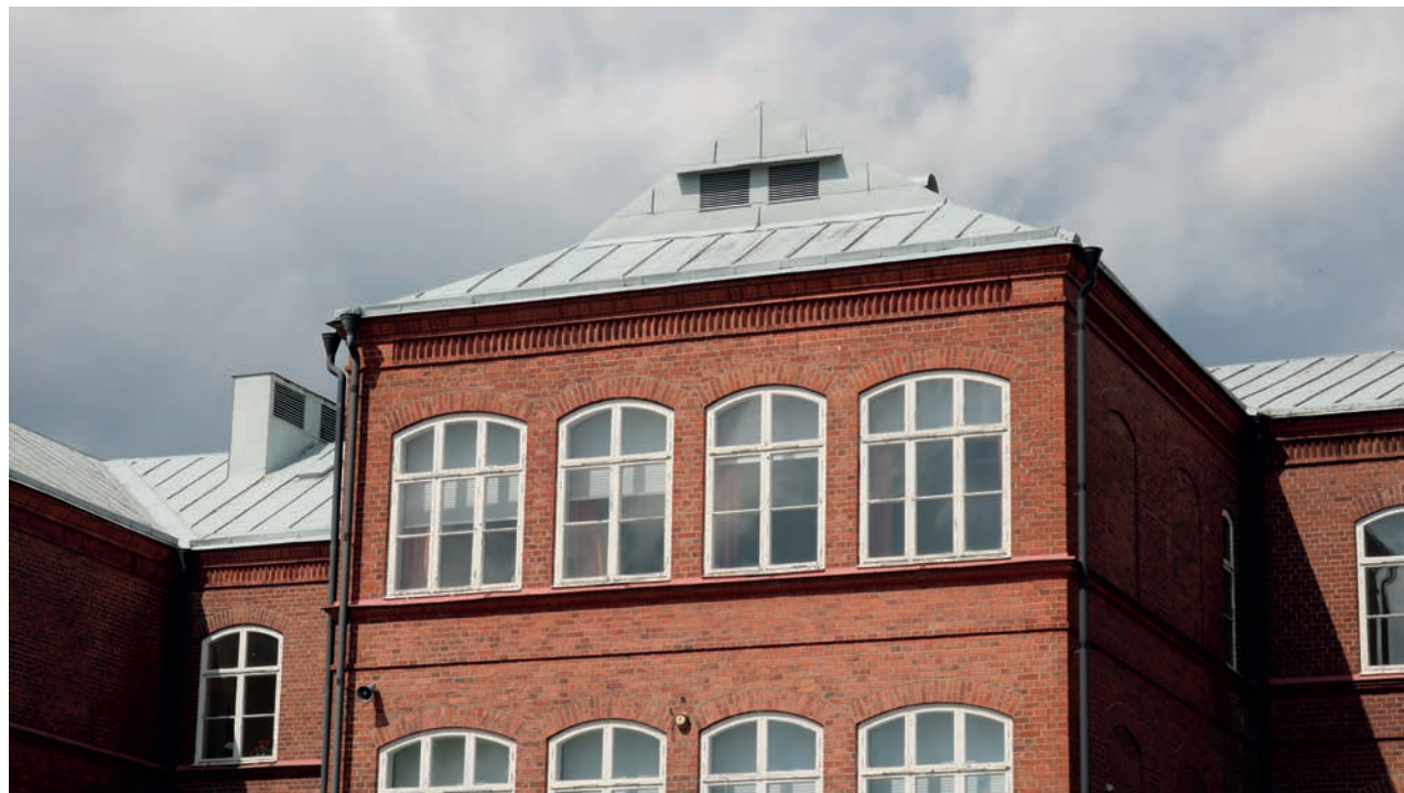
Byggnadens äldre taktäckningsmaterial och fönstersnickerier utgör en del av dess värdebärande egenskaper.
