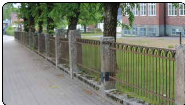
Staket i smide med staketstolpar i huggen granit längs Norra Storgatan.
