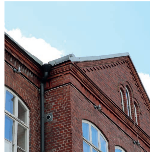
Omsorgsfullt gestaltade fasaddetaljer som murad gesims och takfot (nedan)
