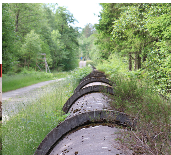
Tuben som leder vattnet till kraftstationen.
