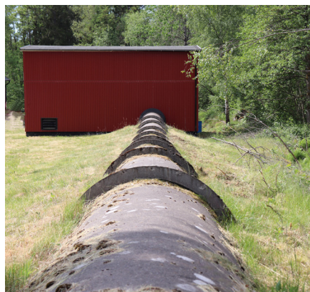
Förvärv av Vikafors Kraftstation under 2021
