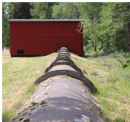
Förvärv av Vikafors Kraftstation under 2021
