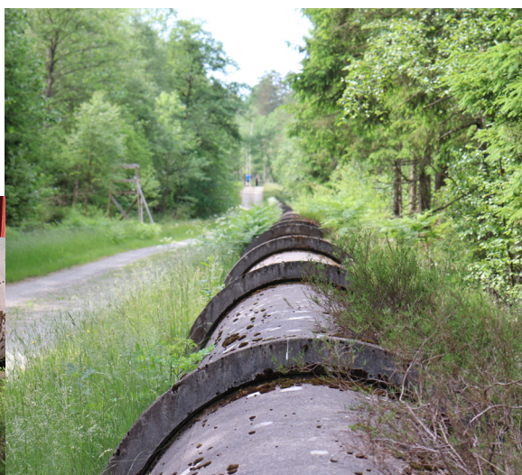
Tuben som leder vattnet till kraftstationen.
