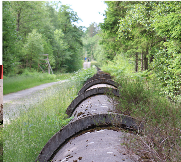
Tuben som leder vattnet till kraftstationen.
