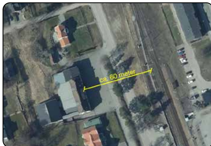
Cirka 60 meter till närmaste järnvägsspår från befintlig byggnation.
