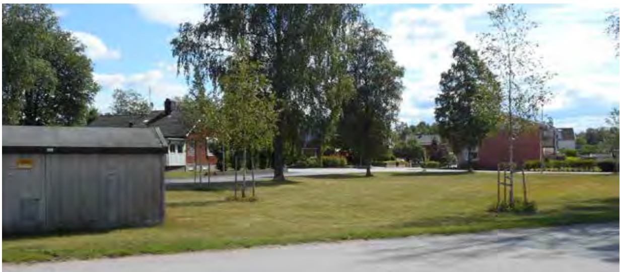
Foto över befintlig parkmark i planområdets östra hörn. Grönytan säkerställs som park och kommer fortsätta att skötas av Gislaveds kommun. Till vänster i bild syns transformatorstation inom föreslaget E-område.
