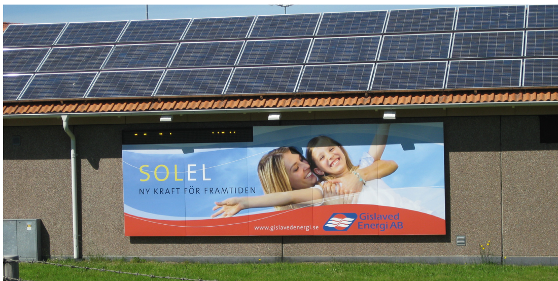
Solenergi vid Gislaved Energi
