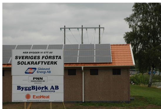
Solenergi vid Gislaved Energi
