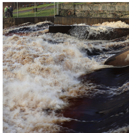
Högt vattenflöde i Nissan vid Gyllenfors kraftstation februari 2020.
