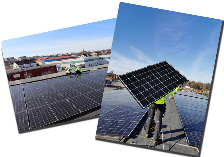
Bilder från taket vid monteringen
