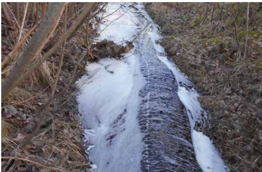
Foto över dagvattendike som flyttas. Längst bort i bild finns befintlig kulvert under Dals-torpsvägen.
