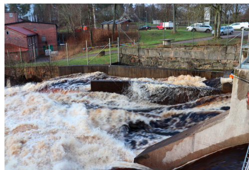
Renovering av Gyllenfors vattenkraftverk.
