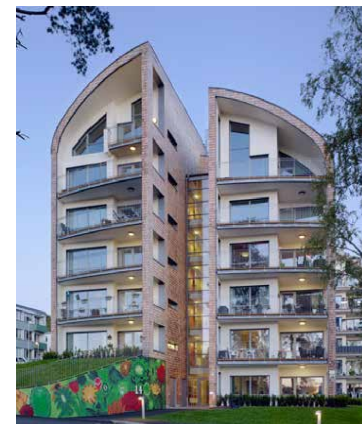
Modernt byggande i trä. Fribo i Fristad
