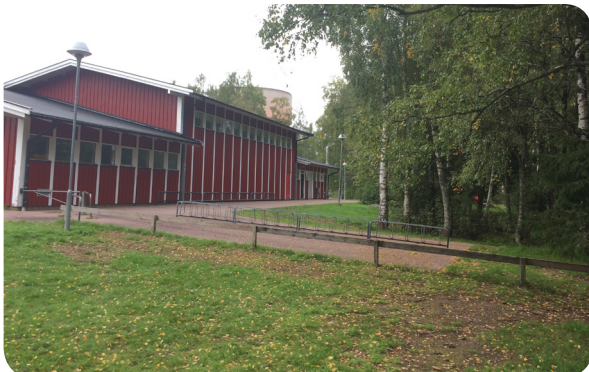
Cykelparkering på östra sidan av gymnastiksalen
